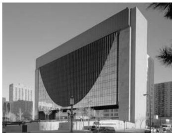
Figura: Banco de la reserva federal, Mineapolis
