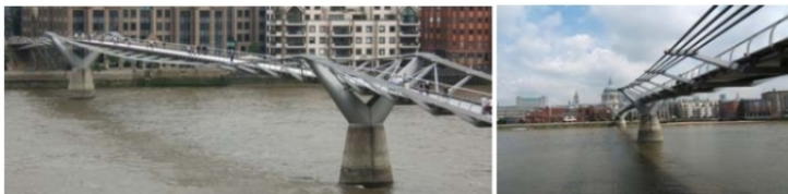
Figura: Millenium Bridge, Londres.
